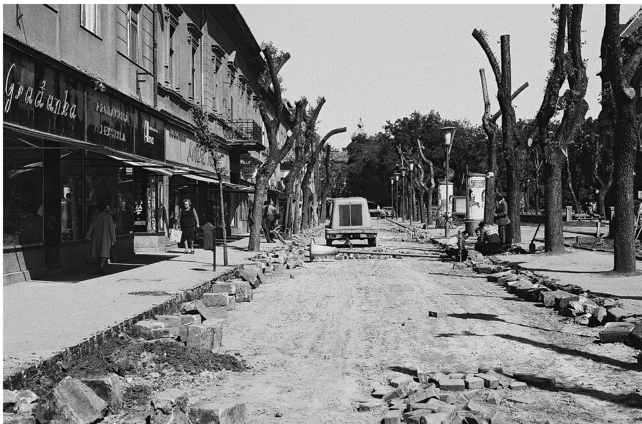
Штросмајерова улица током реконструкције
