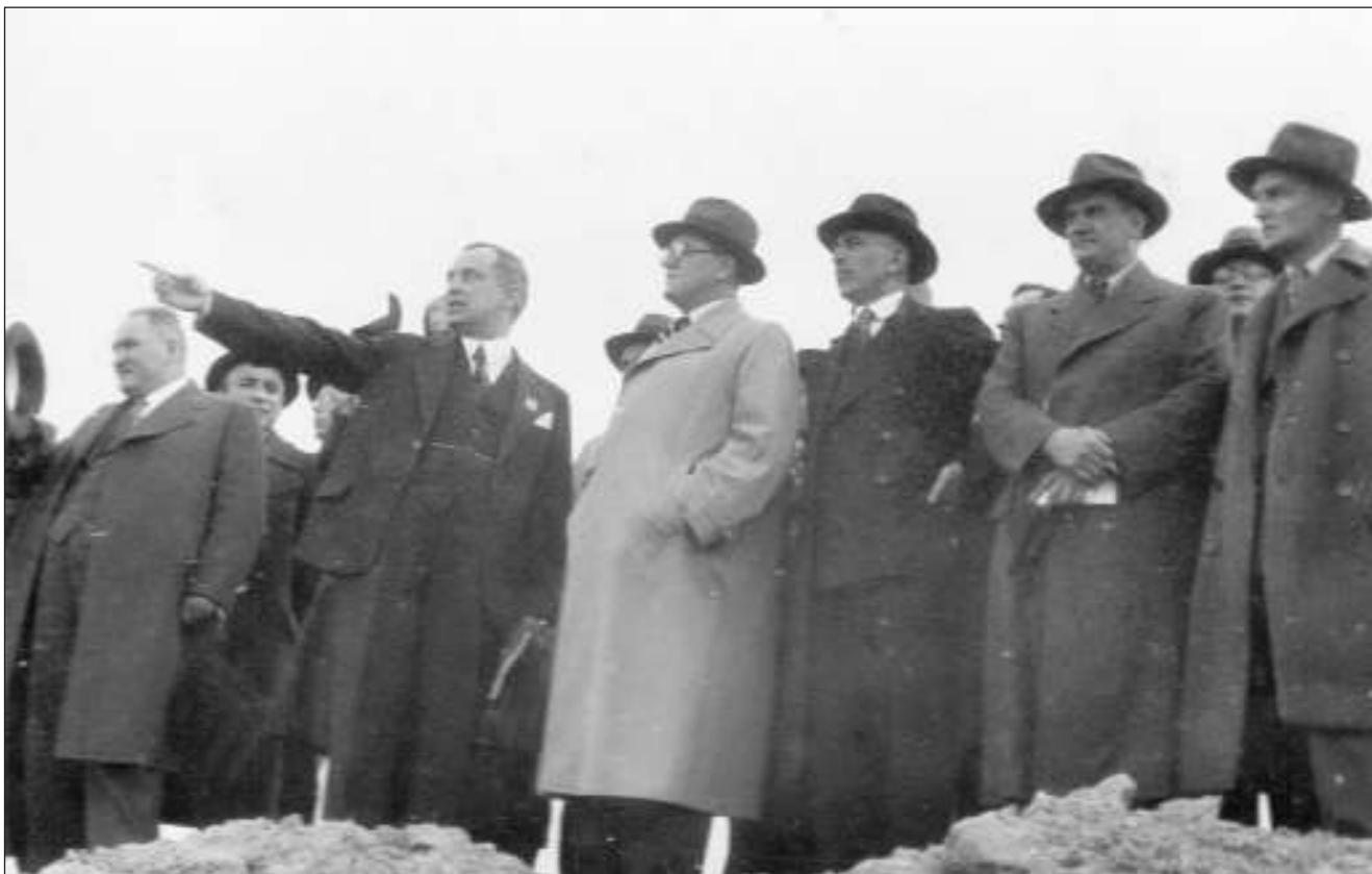
Petrović sa ministrom fizičke kulture Josipom Rogićem i subotičkim funkcionerima na gradilištu stadiona, 1936. (Iz zbirke GMS)
